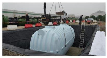
Figure 3 : Levage du réservoir RoDrive dans la fosse de construction préparée
