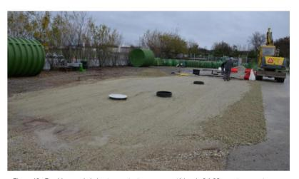
Figure 12 : Remblayage de la hauteur restante avec un matériau de 0 à 32 mm et compactage au compactage approprié
