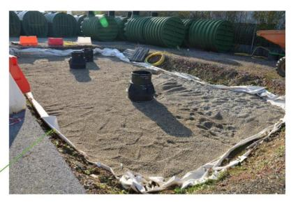
Figure 8 : Achèvement du remblayage avec du gravier 4-8 mm
