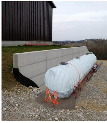
Figure 18 : Mise en œuvre du mur de soutènement en béton contre objet ou sol glissant
