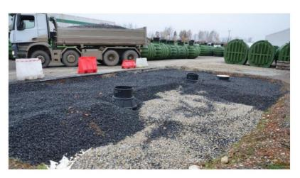
Figure 10 : Enterrement avec le matériau tampon 0 - 64 mm
