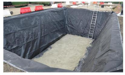
Figure 2 : Protection de la fosse avec géotextile et préparation du lit de sable
