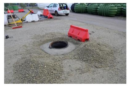
Figure 13 : Pose de l'anneau en béton armé et pose du fer DN600 D400
