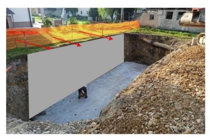
Figure 17 : Mise en œuvre du mur de soutènement en béton
