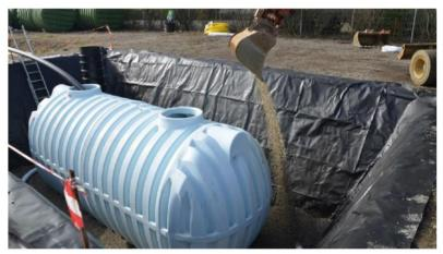
Figure 4 : Remplissage du réservoir d'eau et remblayage de la fosse de construction
