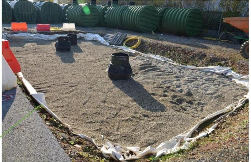
Figure 8 : Achèvement du remblayage avec du gravier 4-8 mm
