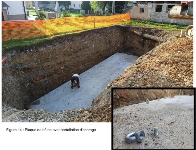
Figure 14 : Plaque de béton avec installation d'ancrage
