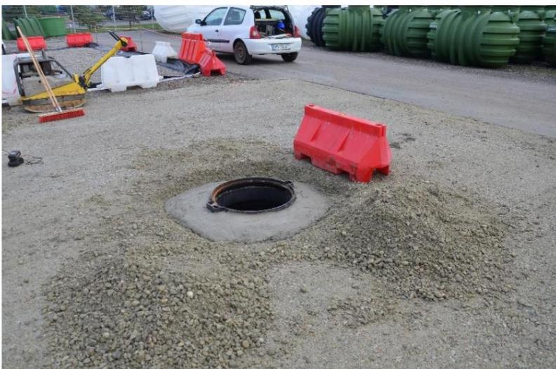
Figure 13 : Pose de l'anneau en béton armé et pose du fer DN600 D400 couvertures moulées
