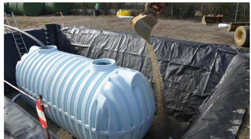
Figure 4 : Remplissage du réservoir d'eau et remblayage de la fosse de construction
