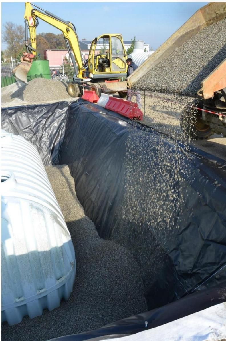
Figure 7 : Remplissage du réservoir d'eau RoDrive avec du gravier 4-8 mm
