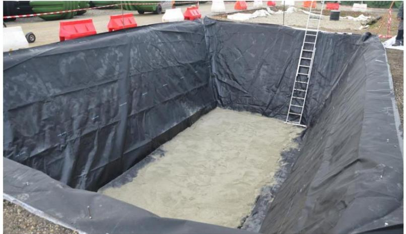
Figure 2 : Protection de la fosse avec géotextile et préparation du lit de sable
