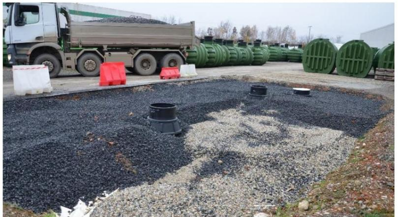
Figure 10 : Enterrement avec le matériau tampon 0 - 64 mm
