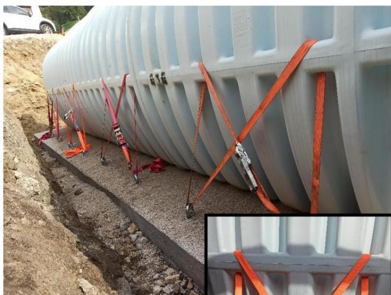
Figure 16 : Exemple d'ancrage
