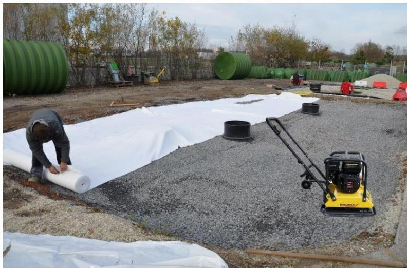
Figure 11 : Le géotextile empêche le mélange et le lavage du matériau de 0 à 64 mm
