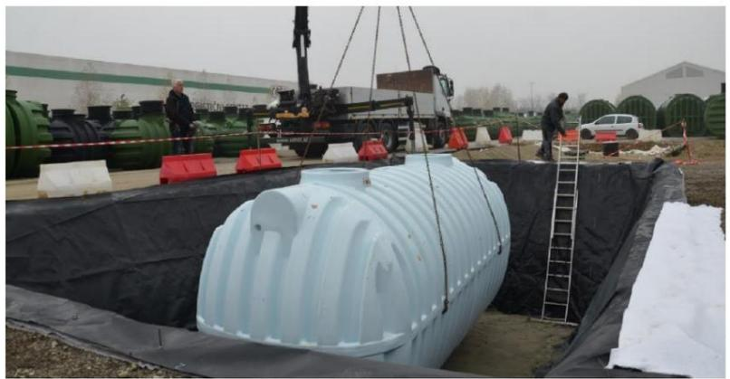
Figure 3 : Levage du réservoir RoDrive dans la fosse de construction préparée
