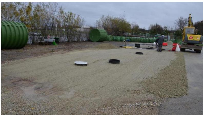
Figure 12 : Remblayage de la hauteur restante avec un matériau de 0 à 32 mm et compactage au compactage approprié
