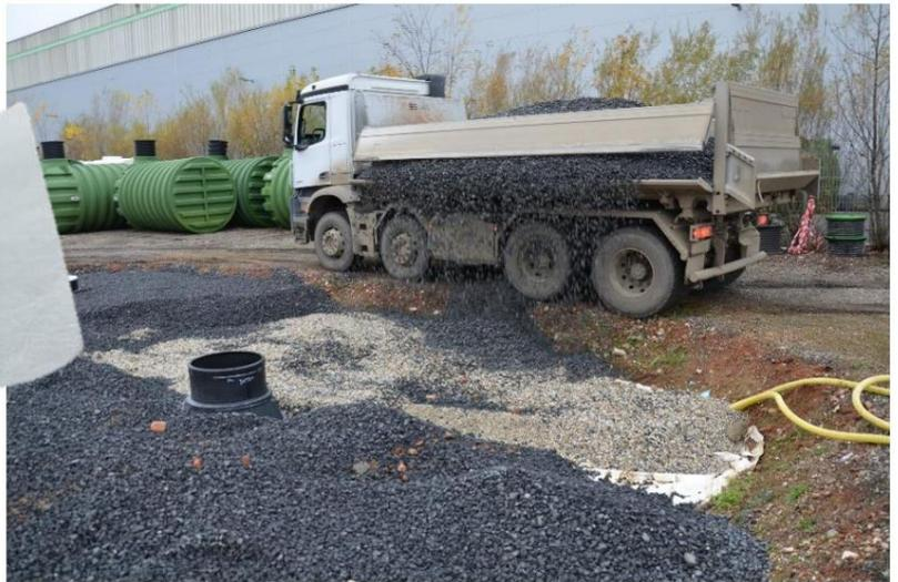
Figure 9 : Enterrement avec le matériau tampon 0 - 64 mm
