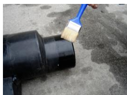
Lubrification du bord de l'embout étagé
