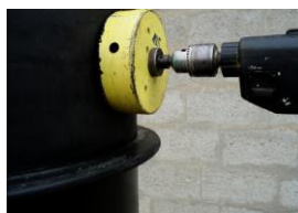
Perçage du trou d'entrée à l'aide d'un trépan à couronne et d'une machine de forage appropriés
