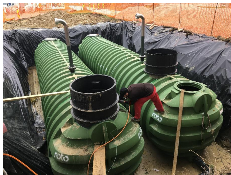
Exemple : Pelle BS - 80 m3 d'eau d'extinction dans une nappe phréatique élevée
