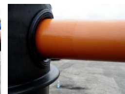
Raccordement du tuyau au trou d'homme
