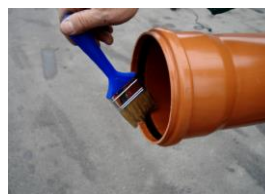
Lubrification des tuyaux en PVC et des joints d'étanchéité
