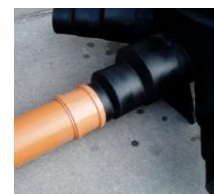
Raccordement d'un tuyau en PVC
