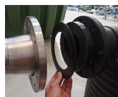
Insertion du joint de bride
