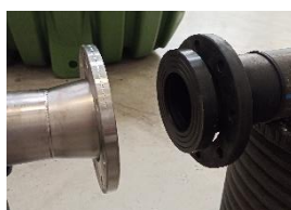
Bride d140 RF et PE prête à être assemblée
