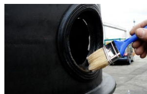
Insertion et lubrification du joint d'entrée et du tuyau en PVC
