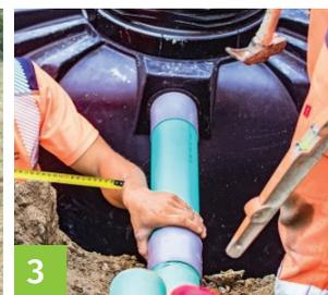
**2-Sortie des eaux prétraitées de la fosse toutes eaux vers le filtre compact** (fig. 4) Tournez le T vers le haut à 45° (en attente du raccordement de la ventilation secondaire) Le T est placé entre 2 manchons.
