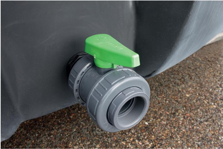
Vanne PVC DN50 et passe-cloison
